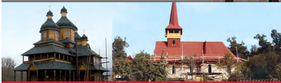
Eglises en construction : Ukraine et diocèse de Maramures, Roumanie
